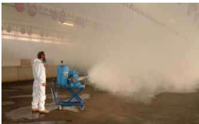
Figure 5 : Traitement biocide d'un bâtiment d'élevage vide par thermonébulisation. La solution insecticide est pulvérisée en fines gouttelettes qui assure une large répartition aérienne de la substance [26].
