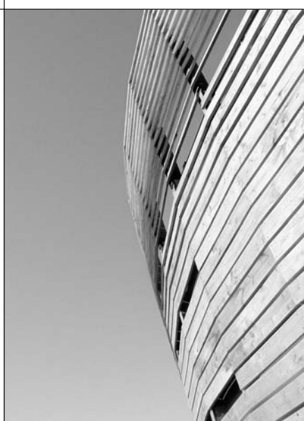
Les revêtements extérieurs en bois constituent l'un des marchés potentiels pour le bois traité par oléothermie.
